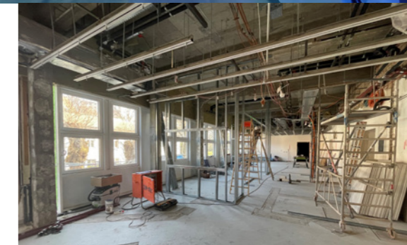
Entkernung der Räume Röntgen 15 und 16
